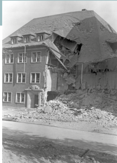
KRIEGSBESCHÄDIGTER BLOCK FÜRSTENBERGSTRASSE 14, 1943
