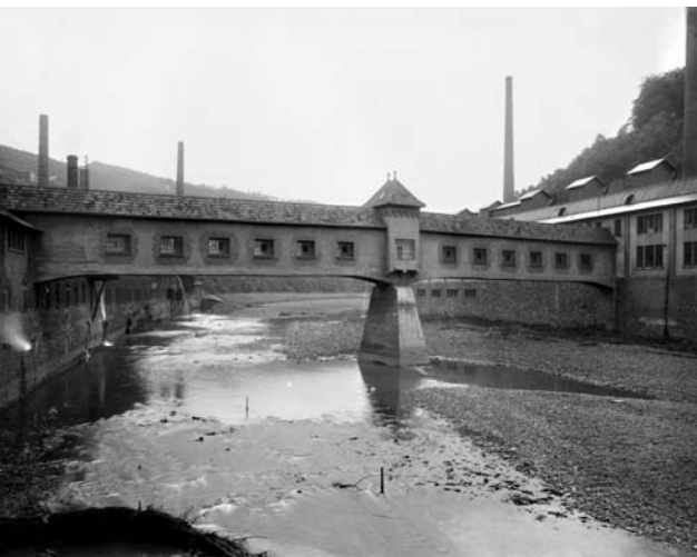
4 Wehrsbrücke Basse & Selve. Foto um 1920.
