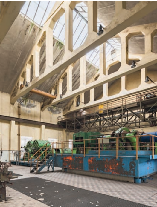
6 Dachkonstruktion des Erweiterungsbaus der Maschinenhalle der Zeche Heinrich Robert der Schachtanlage Bergwerk Ost in Hamm. Foto 2023.
