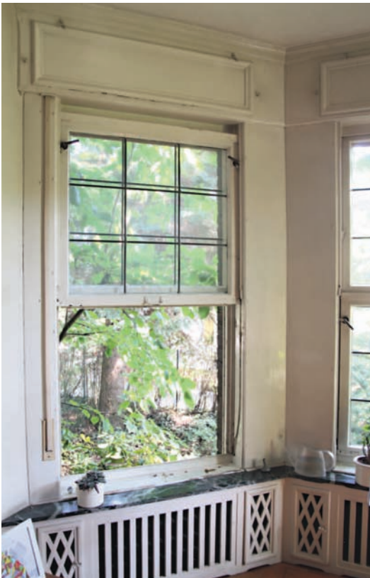
4 Recklinghausen, Wohnhaus, vertikales Schiebefenster von 1925. Foto 2019.
