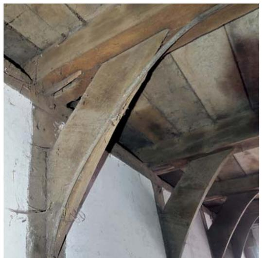
8 Nördliche Dielenwand, Detailansicht der Deckenbalkenlage über der Diele mit queraussteifenden Kopfbändern des Kernbaugesüges von 1558 (d). Die Kopfbänder zeigen an ihrer Unterseite eine sorgfältig ausgearbeitete Kehlung. Foto 2023.
