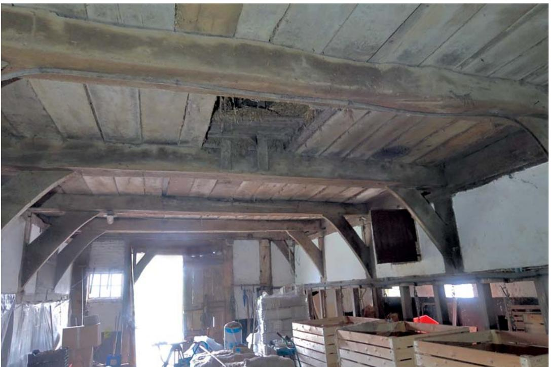
6 Diele mit Blick nach Osten. Die bauzeitlichen großformatigen Deckenbalken sind an beiden original erhaltenen Dieleiwänden mit quer- und längsaussteifenden Kopfbändern stabilisiert. Foto 2023.
