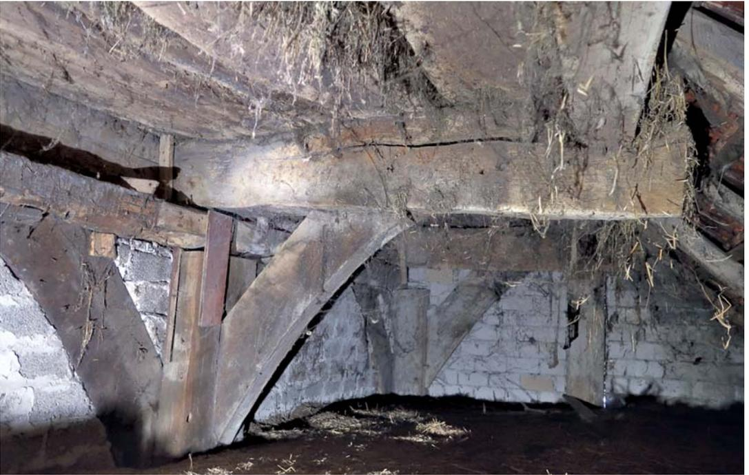
9 Queraussteifende und längsaussteifende Kopfbänder im Bereich der südlichen Dielenwand, von der Hille aus gesehen (Blick nach Osten). Der Dachbalken des Zweiständer-Dielenhauses kragt zum Seitenschiff 2 Meter aus, in seiner Außenseite liegt die Sparrenschwelle. Foto 2023.
