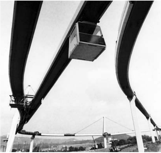
2 Die Hagener Versuchsstrecke für das Cabinentaxi. Foto 1973.
