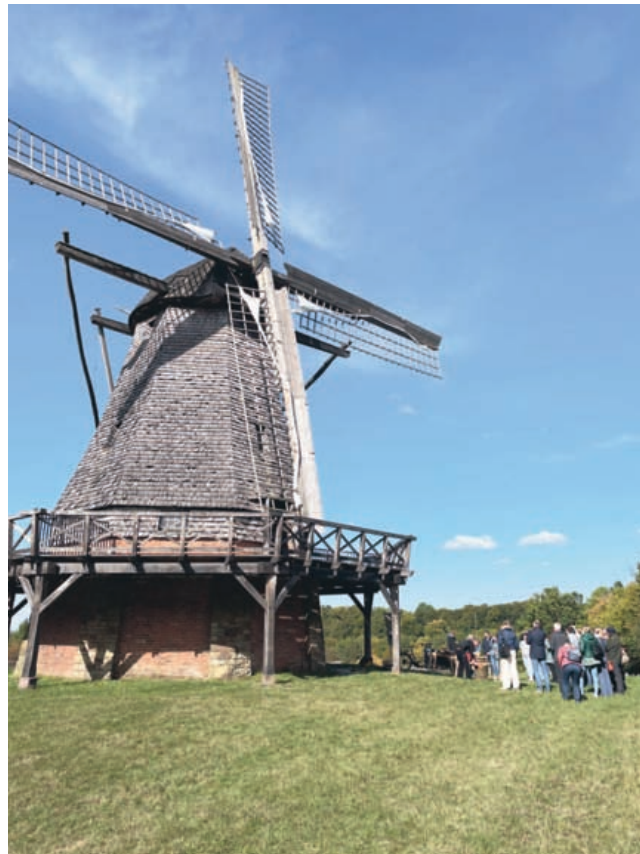
1 An der Kappenwindmühle wurde die Dacheindeckung mit Holzschindeln vorgestellt.
