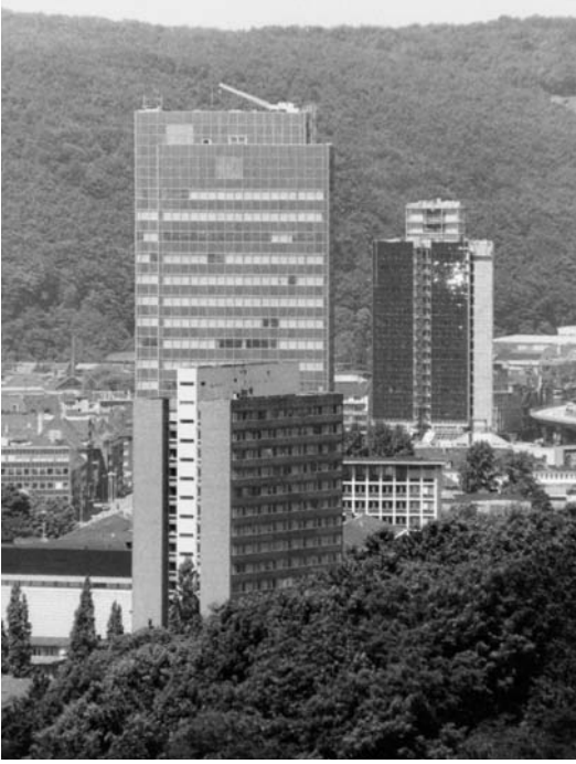
7 Blick auf die Innenstadt mit Hochhausgruppe. Foto 1981.
