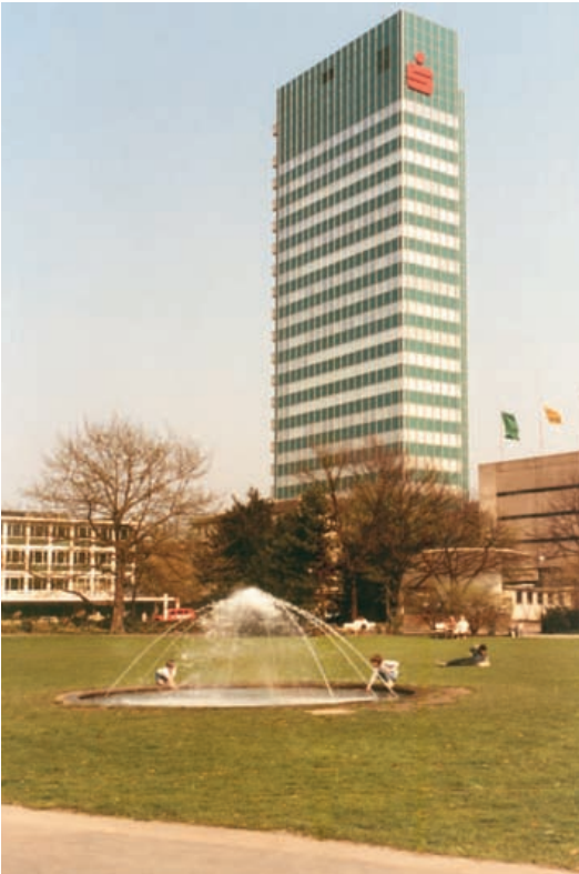
5 Das Hochhaus der Sparkasse nach Fertigstellung. Foto 1985.
