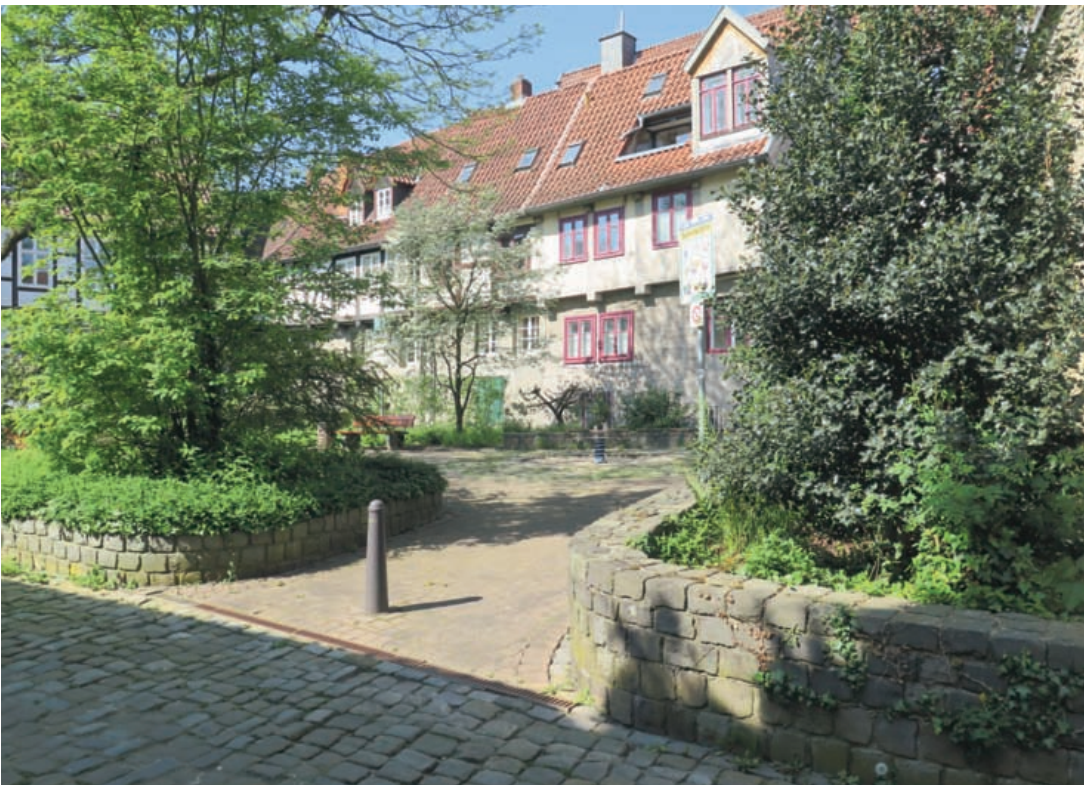
3 Detmold, Stadtplatz 2 (seit 2015 Oskar-Brüsewitz-Platz) in einer altstädtischen Hofsituation an der Grabenstraße, angelegt 1987/88. Foto 2024.
