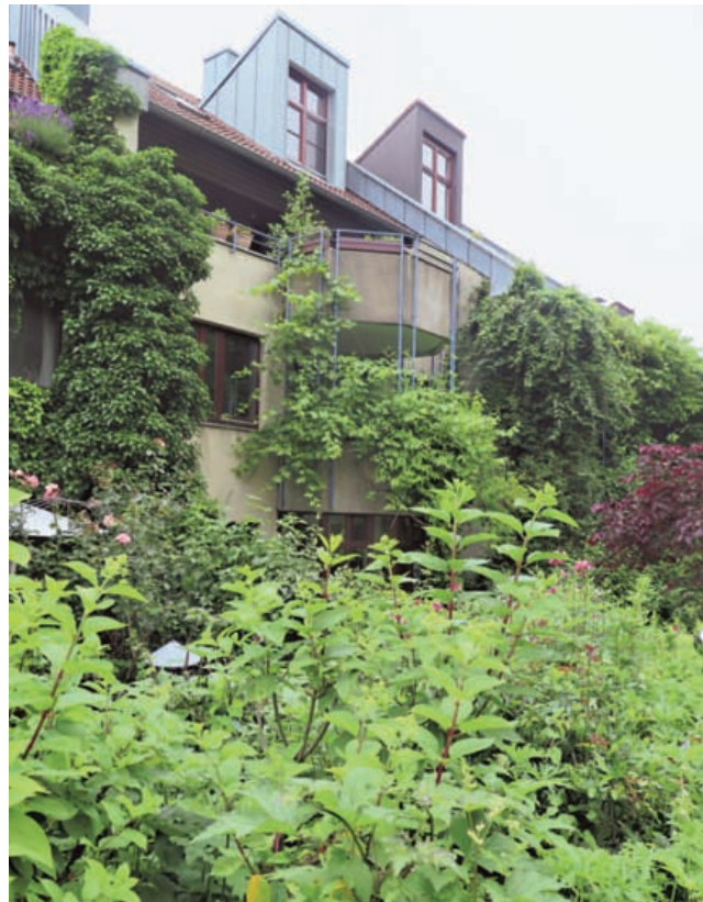
5 Bochum, KoWo-Garten, Fassadenbegrünung an der Straßenseite. Foto 2024.
