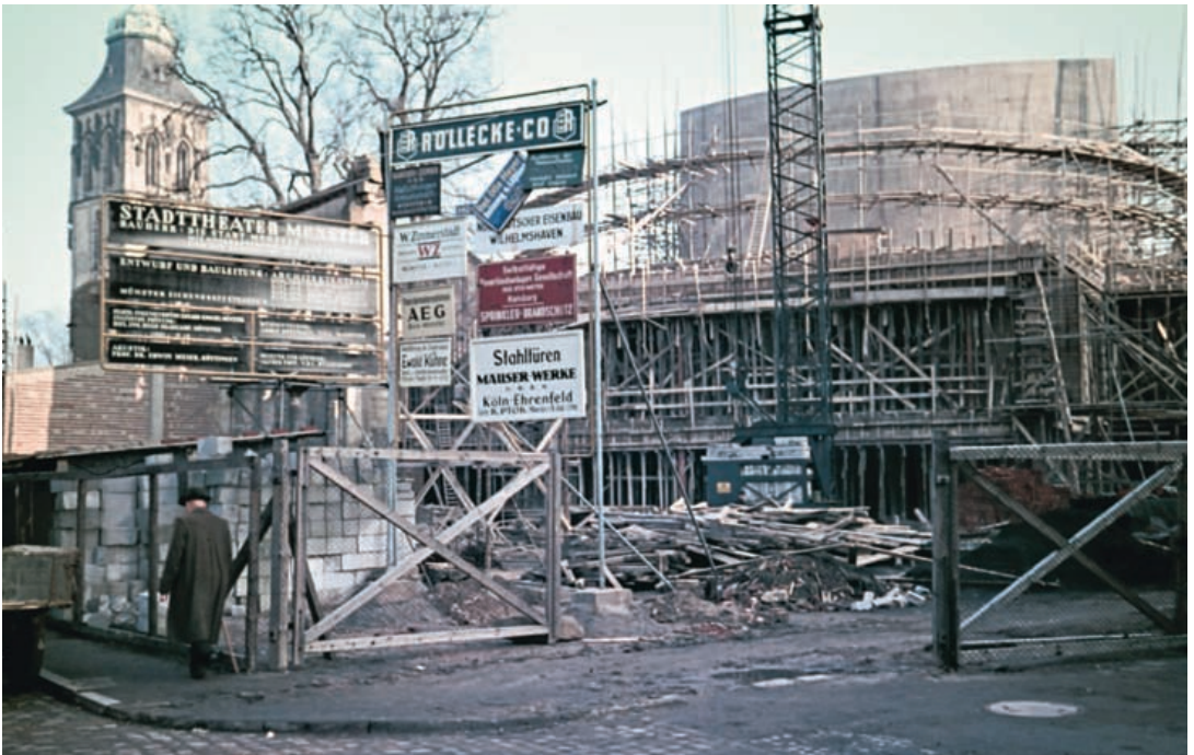
14 Theater Münster als Baustelle. Foto 1954.
