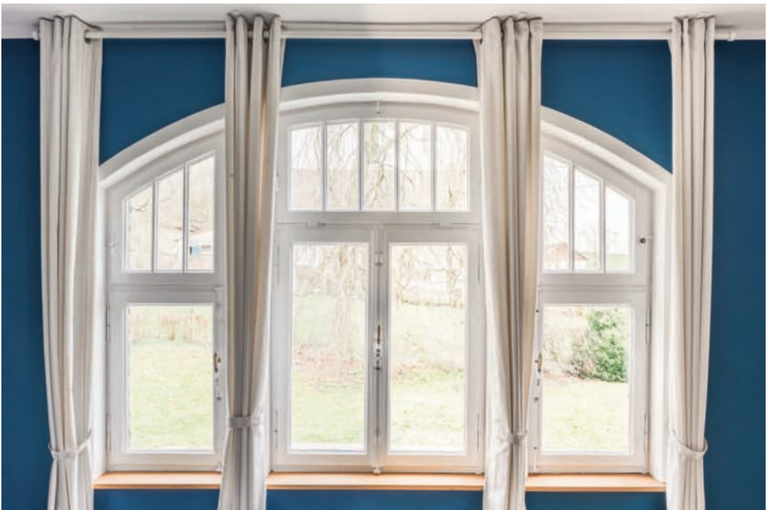
6 Fenster im Wohnzimmer, Erdgeschoss Ostfassade. Foto 2024.
