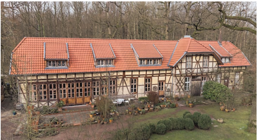
2 Außenaufnahme mit Zierfachwerk. Foto 2024.
