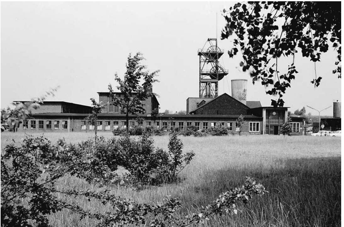
2 Vollausbau der Anlage mit altem Grubenlüfter. Foto 1958.
