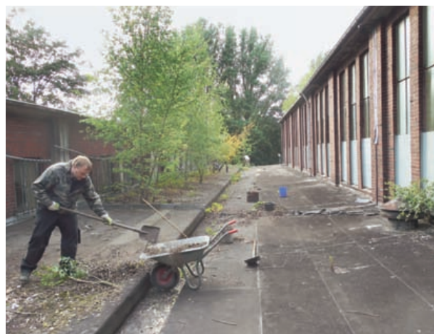
5 Vorbereitung der Dachsanierung im Sommer 2015.
