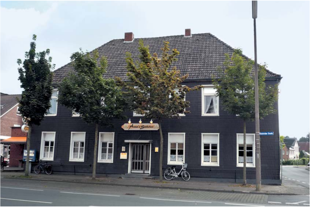
1 Wiedenbrück, Bielefelder Straße 6, Haus von Südwesten. Foto 2016.
