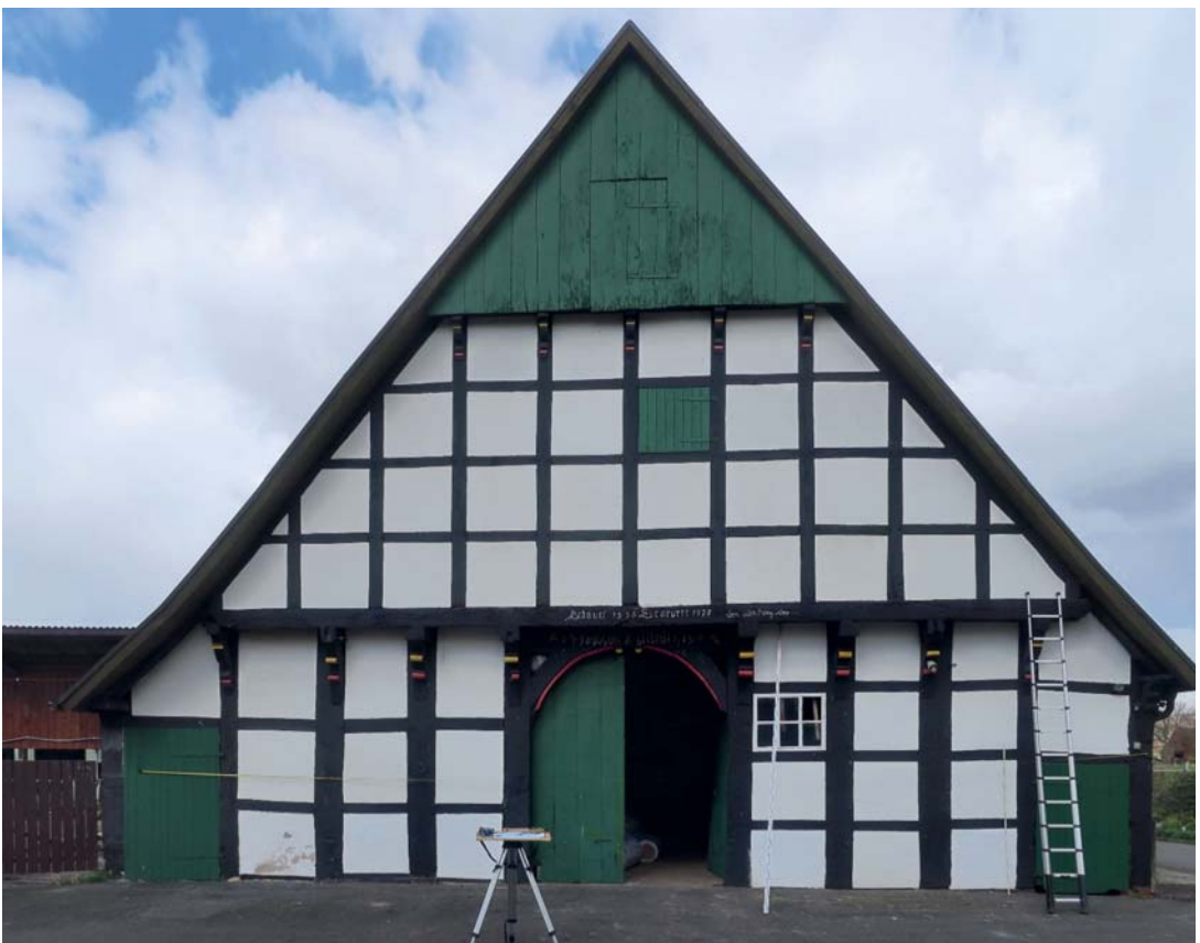
2 Ostgiebel, Wirtschaftsgiebel des Haupthauses mit Kernbaugesüge von 1558 (d, i), mit dem Torrahmen mit Torbalken und Hausinschrift sowie sechs originalen Ständern mit dazugehörigen eingehälsten Stichbalken und Taubandknagen, darüber der Dreiecksgiebel von 1777. Foto 2023.
