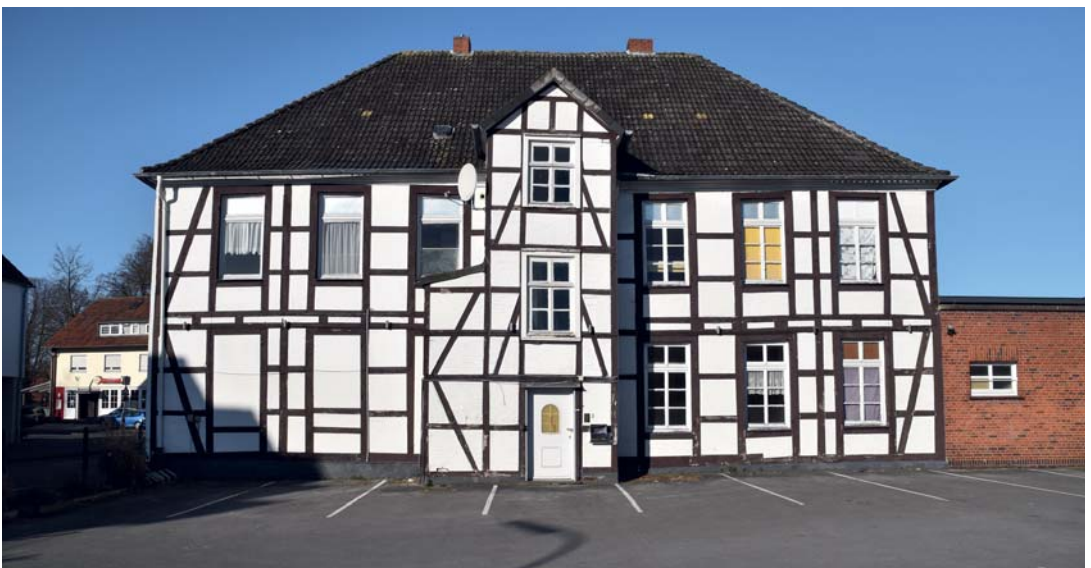
3 Bielefelder Straße 6, Ansicht von Osten; mittig Treppenhauseinbau von 1882; rechts Abortanbau aus Backstein von 1982. Foto 2022.
