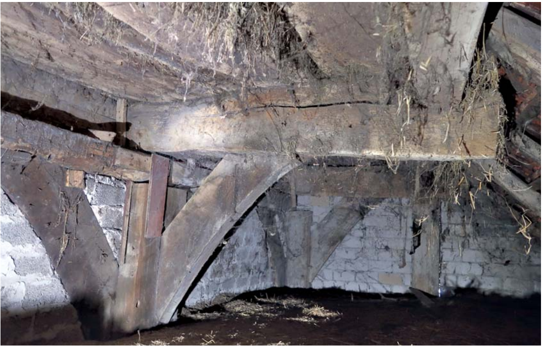
9 Queraussteifende und längsaussteifende Kopfbänder im Bereich der südlichen Dielenwand, von der Hille aus gesehen (Blick nach Osten). Der Dachbalken des Zweiständer-Dielenhauses krägt zum Seitenschiff 2 Meter aus, in seiner Außenseite liegt die Sparrenschwelle. Foto 2023.
