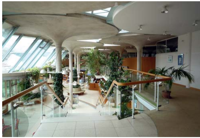
5 „Weiche“ Verwendung von Sichtbeton beim Kurgastzentrum in Bad Salzuflen (1981–1983) von Behnisch & Partner: Die „Betonpilze“ sind durch kontrastierende Holzoberflächen und Bepflanzung in ihrer Wirkung zurückgenommen. Foto 2009.
