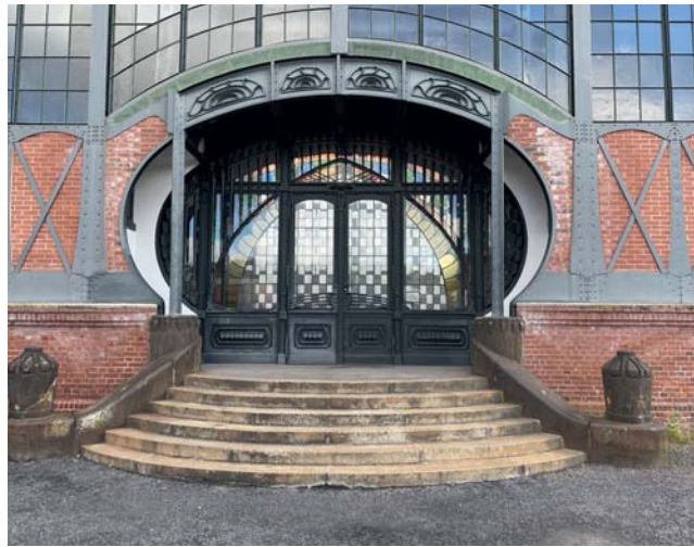
2 Das prächtige Jugendstil-Portal der Maschinenhalle von Bruno Möhring war eine Station beim Rundgang über das Zechengelände.
