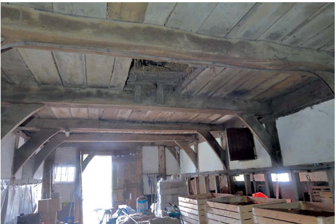
6 Diele mit Blick nach Osten. Die bauzeitlichen großformatigen Deckenbalken sind an beiden original erhaltenen Diehlenwänden mit quer- und längsaussteifenden Kopfbändern stabilisiert. Foto 2023.
