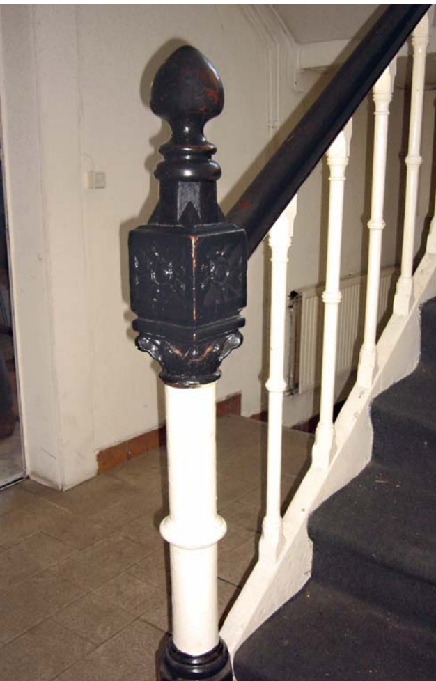
5 Antrittspfosten der Treppe von 1882. Foto 2016.
