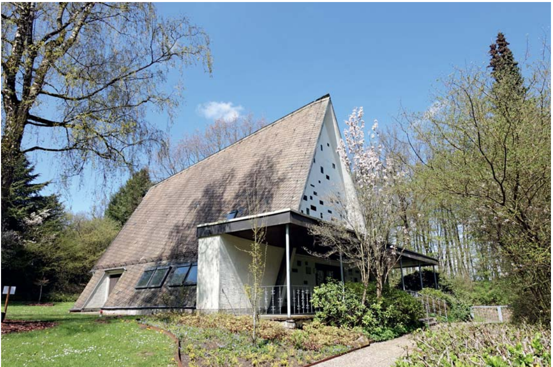
4 Ein prägnantes Element des Baus der 1960er-Jahre ist das für Trauerhallen obligatorische und hier großzügig ausgeführte Vordach, das den Friedhofsbesuchern Wetterschutz bietet und bei besonders großen Trauergesellschaften als erweiterter Innenraum dienen kann.
