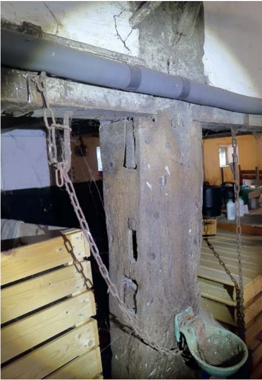
7 Der bauzeitliche Dielenwandständer zeigt die Zapflöcher des einstigen Kuh-Nackenriegels sowie darüber des Hillenriegels. Zum Teil sind die abgeschnittenen Zapfen der einstigen Bauteile noch in situ. Foto 2023.
