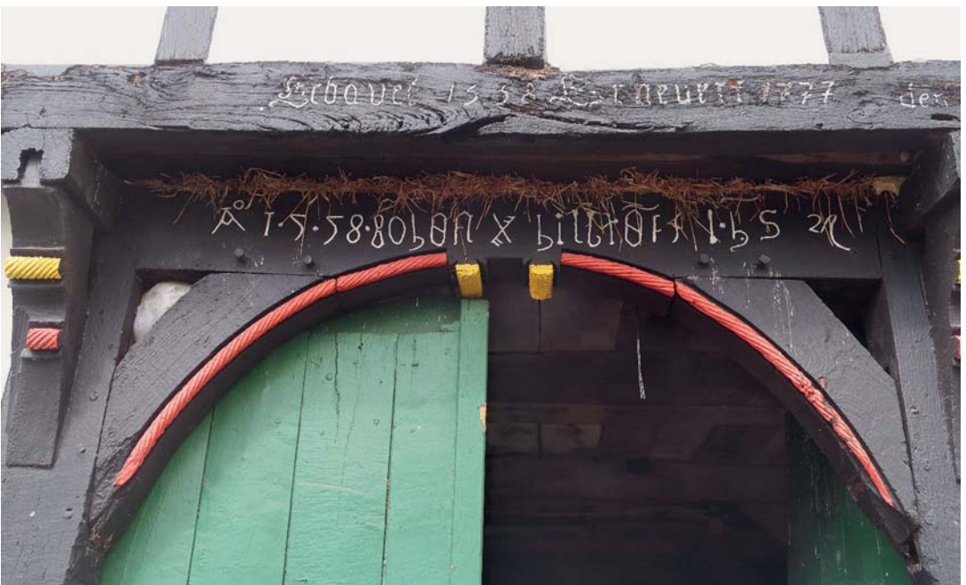
5 Torbalken mit Inschrift „Anno 1558 Johan Hilbrott IHS“. In der Giebelschwelle darüber befindet sich die Reparaturinschrift „Gebauet 1558 Erneuert 1777“. Foto 2023.
