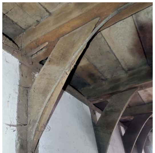
8 Nördliche Dielenwand, Detailansicht der Deckenbalkenlage über der Diele mit queraussteifenden Kopfbändern des Kernbaugefüges von 1558 (d). Die Kopfbänder zeigen an ihrer Unterseite eine sorgfältig ausgearbeitete Kehlung. Foto 2023.
